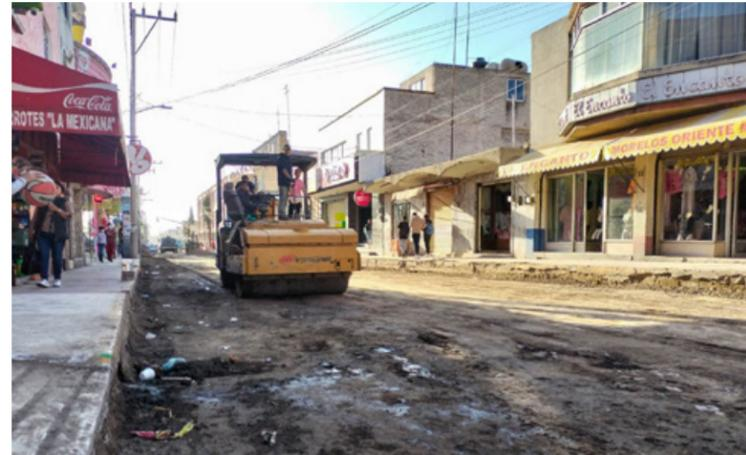
También se construyó pavimento hidráulico con una superficie de 511 metros cuadrados en la calle Comarca Minera entre Boulevard Samuel Berganza y calle Sierra Baja en la Colonia Hidalguense, proyecto que contempló la construcción del muro de contención, guarniciones y banquetas.
